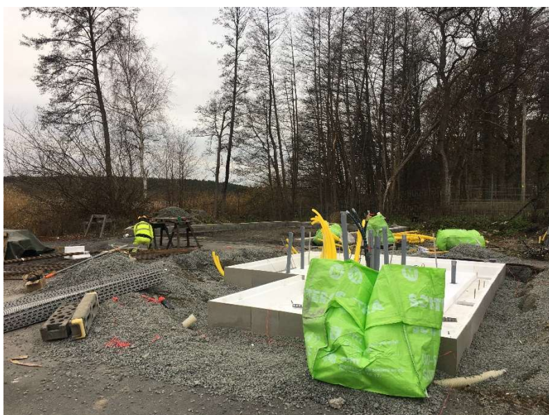
Arbetet med att återuppbygga vaktkur och traktorskjul har börjat
